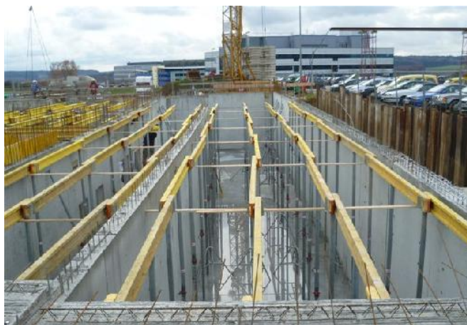
Belastungstabelle Zulassungs-Nr. Z.9.-188 / Zugelassenes Biegemoment M=5,0 \text{ kN/m} / Zugelassene Querkraft Q=11,0 \text{ kN} / Gewicht: ca. 5 \text{ kg/m}
